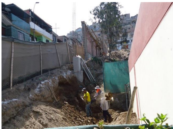
11月16日現在、外壁建造の様子
