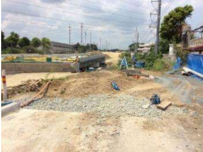
学校前の工事現場
