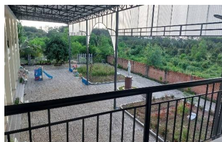
完成した屋根
