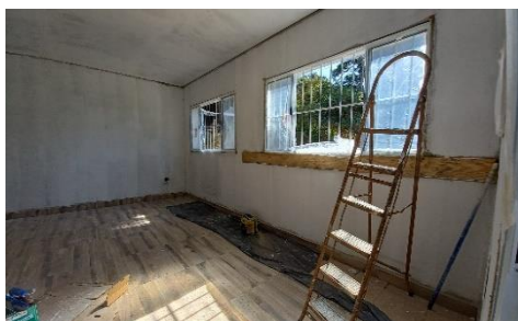
養護施設 内装工事
