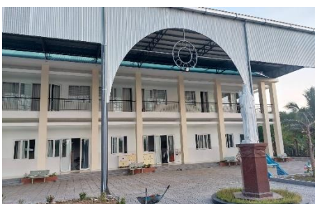
完成した屋根
